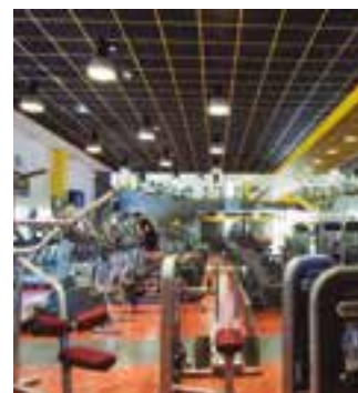
Lo + Fit Galapagar Gym. Madrid, Španělsko. VRF, PACi, vzduchotechnická jednotka
