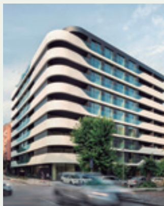
Výnimočná obytná budova s účinným riešením HVAC v Bulharsku. Aquarea
