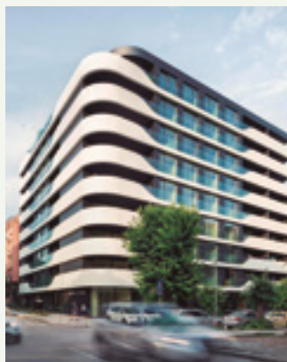
Výjimečná obytná budova v Bulharsku s efektivním řešením klimatizace. Aquarea
