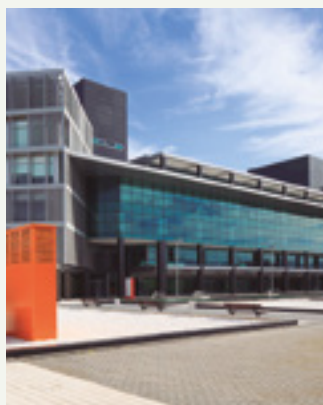
Andalucia Technology Park. Kanceláře s vysokou energetickou účinností. Španělsko. ECOi
