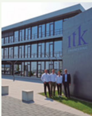
ITK Engineering GmbH. Inovativní kancelářská budova nacházející se v Německu. ECOi-PACi
