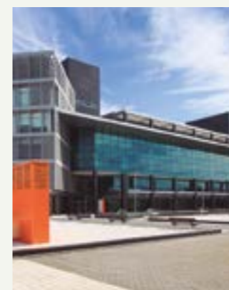
Andalusia Technology Park. Kanceláře s vysokou energetickou účinností. Španělsko. ECOi
