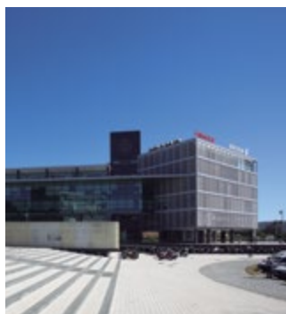
Andalucia Technology Park. Málaga, Španělsko. ECOi
