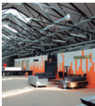
Řešení společnosti Zalando pro přestavbu její kanceláře skladu v Grand Canal Quay, Dublin. ECOi
