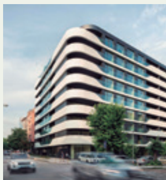
Výnimočná obytná budova s účinným riešením HVAC v Bulharsku. Aquarea
